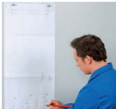
1. Предварительная разметка с помощью монтажного шаблона
